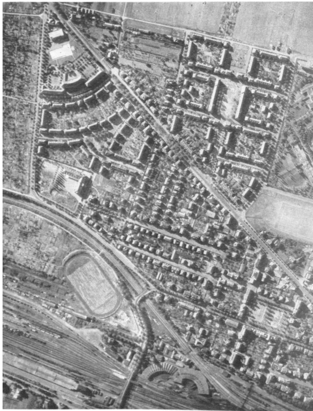
Fig. 83. — PHOTOGRAPHIE AU 1/5 000 D'UN QUARTIER D'EXTENSION (Sainte-Marie, Colmar, Haut-Rhin)
